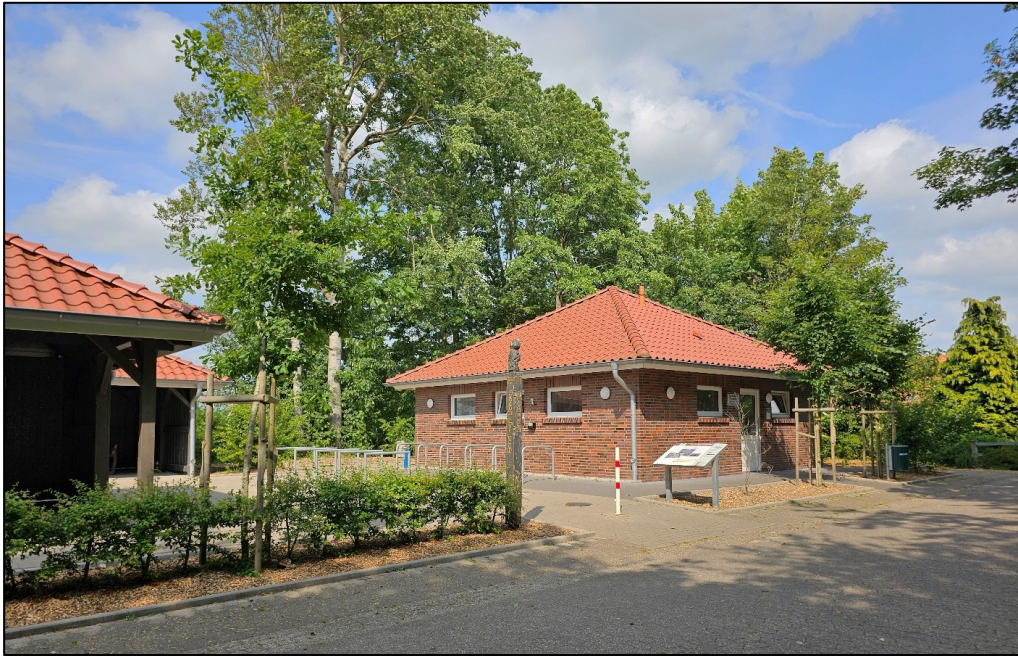
Abbildung 11: Saniertes Sanitätsgebäude, mit Aufladestationen für Elektrofahrräder.
