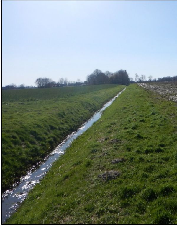
Abbildung 6: Wilberslooger Wasserzug mit Räumstreifen
