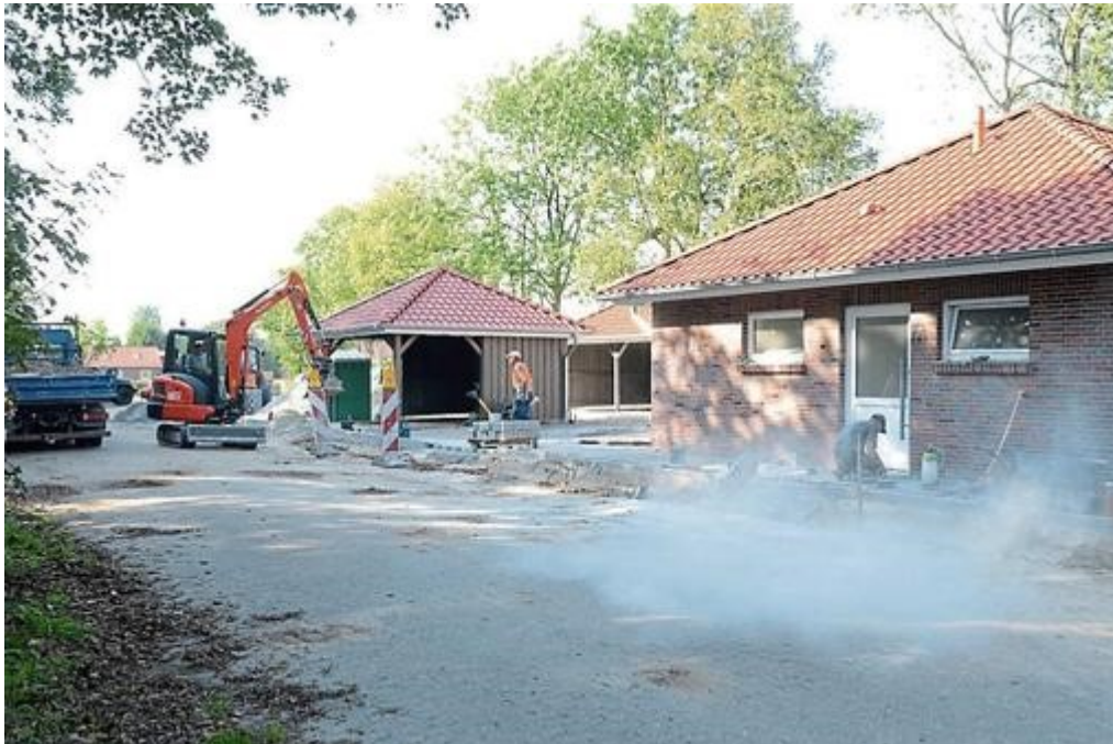
Abbildung 9: Fast fertige Info- und Schutzhütte, saniertes Sanitätsgebäude (Foto: Anzeiger f. Harlingerland, 26.09.2020, Foto Helmut Burmann, Quelle: Internet; https://lokal26.de/holtriem/ ).
