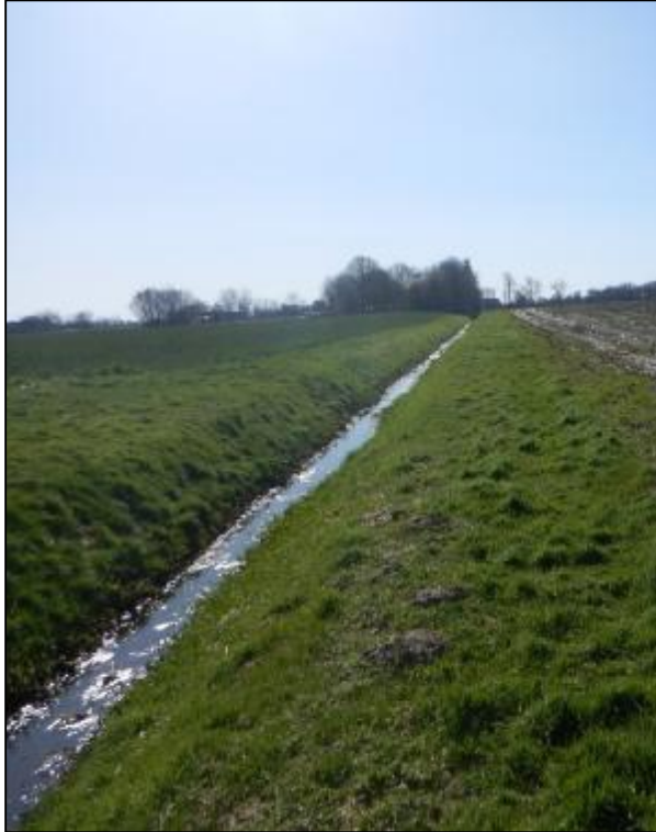
Abbildung 6: Wilberslooger Wasserzug mit Räumstreifen
