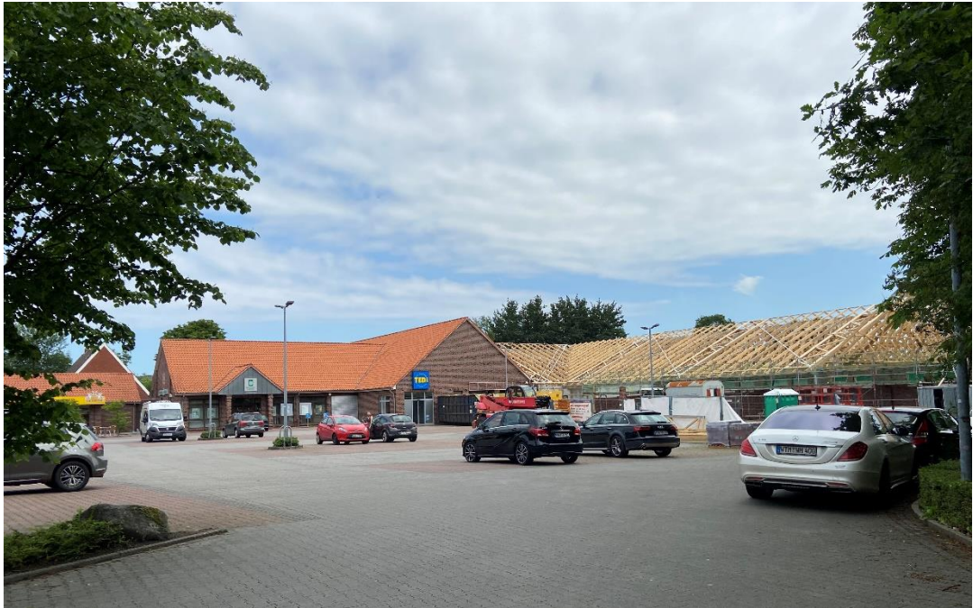
Abbildung 4: Gebäude vom abgebrannten Aldi-Markt im Wiederaufbau an der Dornumer Straße 2
